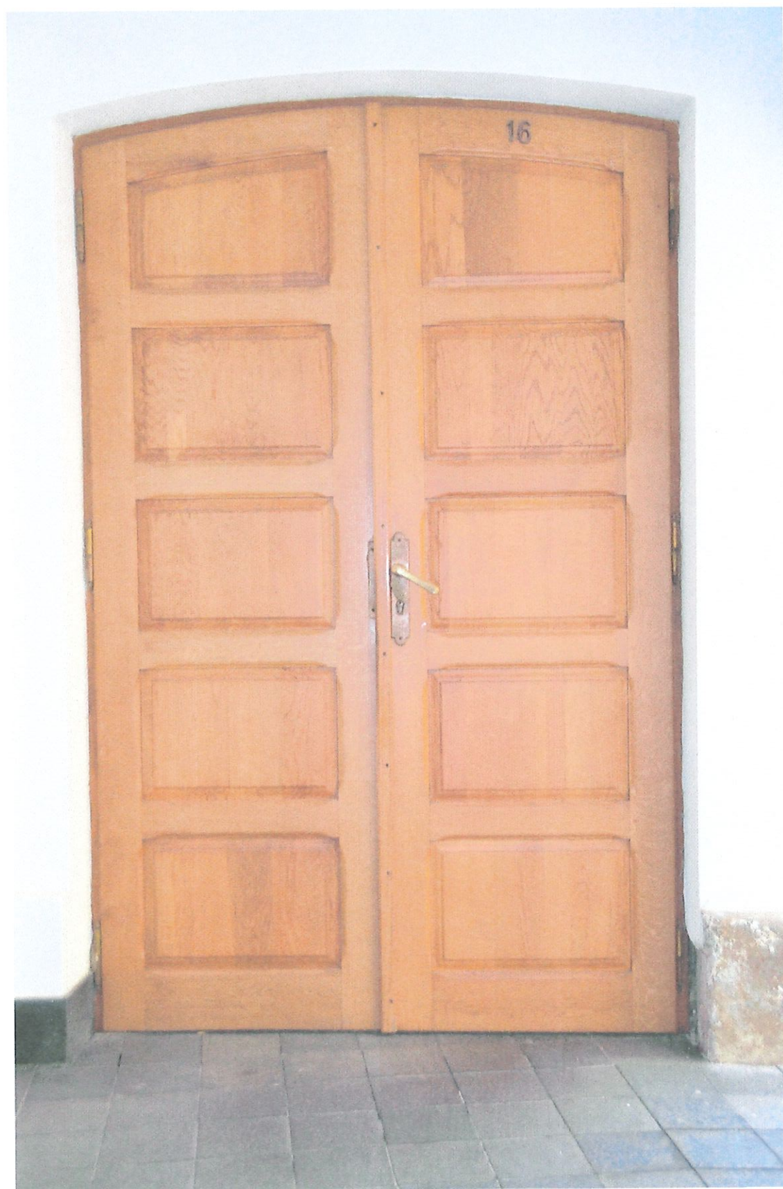
Fot. 8 Muzeum Podkarpackie w Krośnie, ul. Józefa Piłsudskiego 16, 38-400 Krosno, elewacja wewnętrzna – dziedziniec, drzwi drewniane dwuskrzydłowe, fot. R. Kubit 2021 r.
