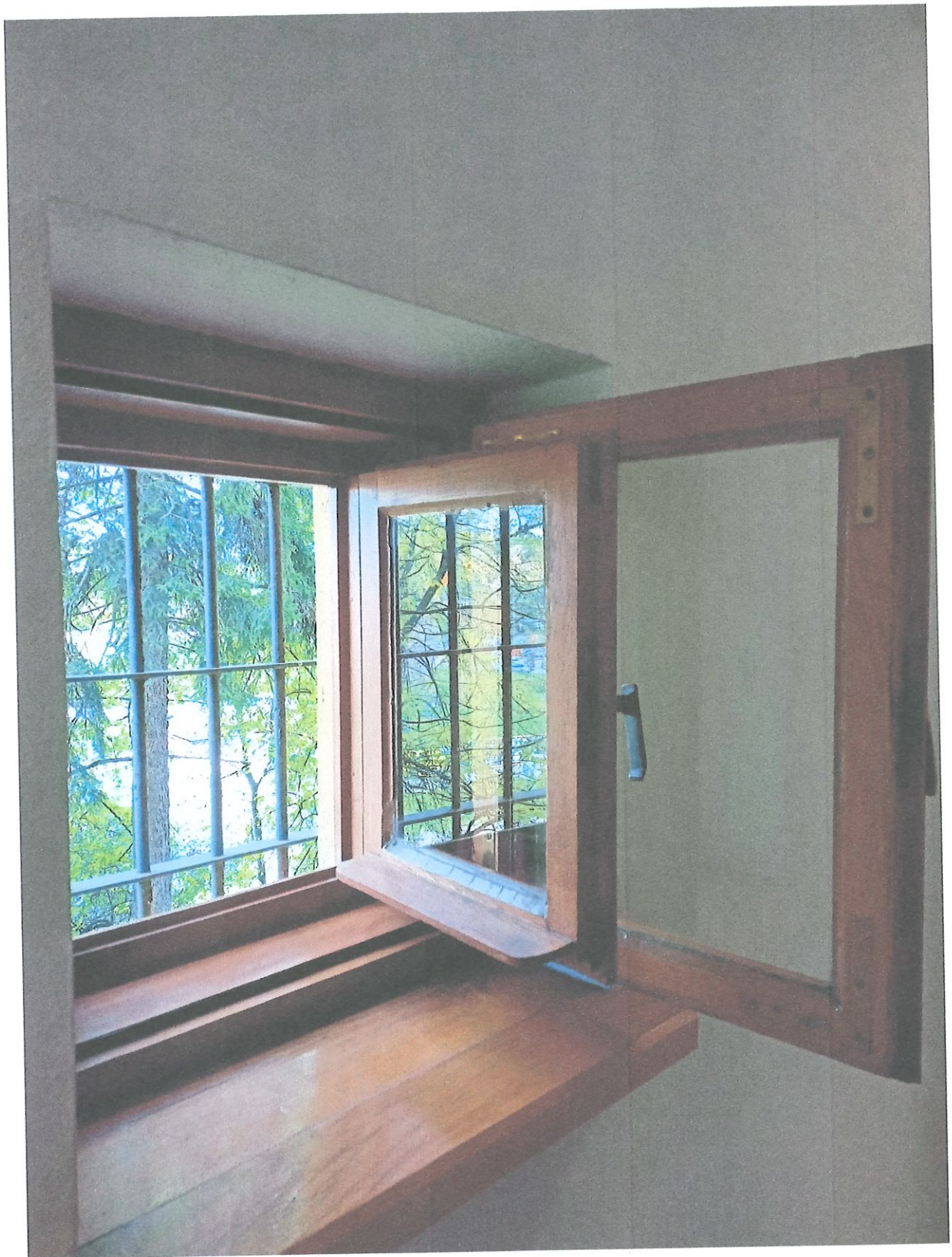
Fot. 4 Muzeum Podkarpackie w Krośnie, ul. Józefa Piłsudskiego 16, 38-400 Krosno, widok z wewnątrz, elewacja od strony ulicy Legionów, jedno z najmniejszych okien drewnianych, fot. K. Witalis 2021 r.
